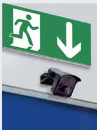
Standaard radarmelder in vluchtrichting
