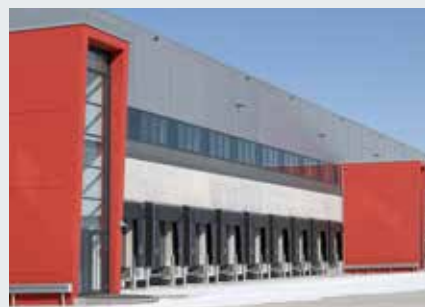
Immogate Logistikcenter, München (D)
